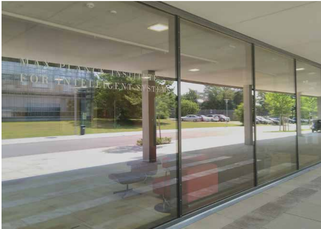
Baustelle und Eingang Max-Planck-Institut im Technologiepark Tübingen Reutlingen, Standort Obere Viehweide
