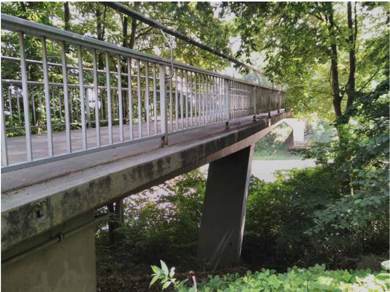
Fußgängerbrücke über den Nordring
