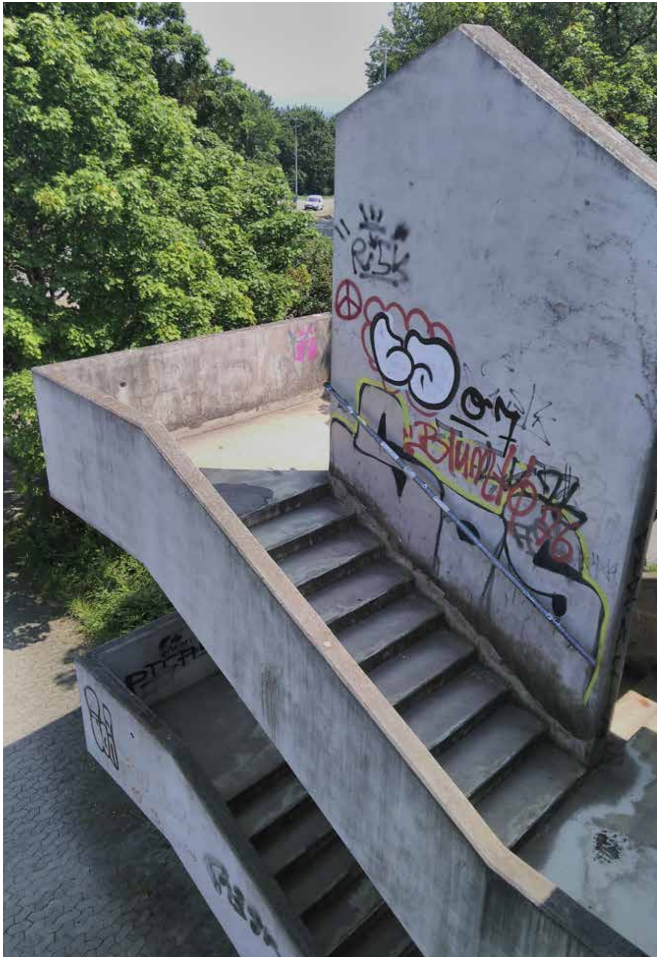
Treppenaufgang vom Studierendendorf auf die Fußgängerbrücke über den Berliner Ring
