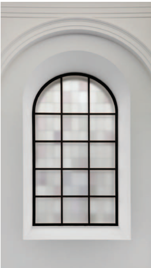
Fenster von Innen
